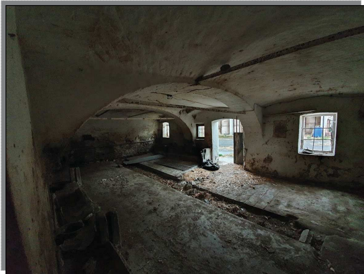
FOTO 11 _ PIANO TERRA: EX-STALLA
