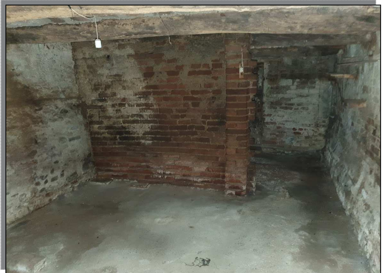
FOTO 4 _ PIANO TERRA: CANTINA
