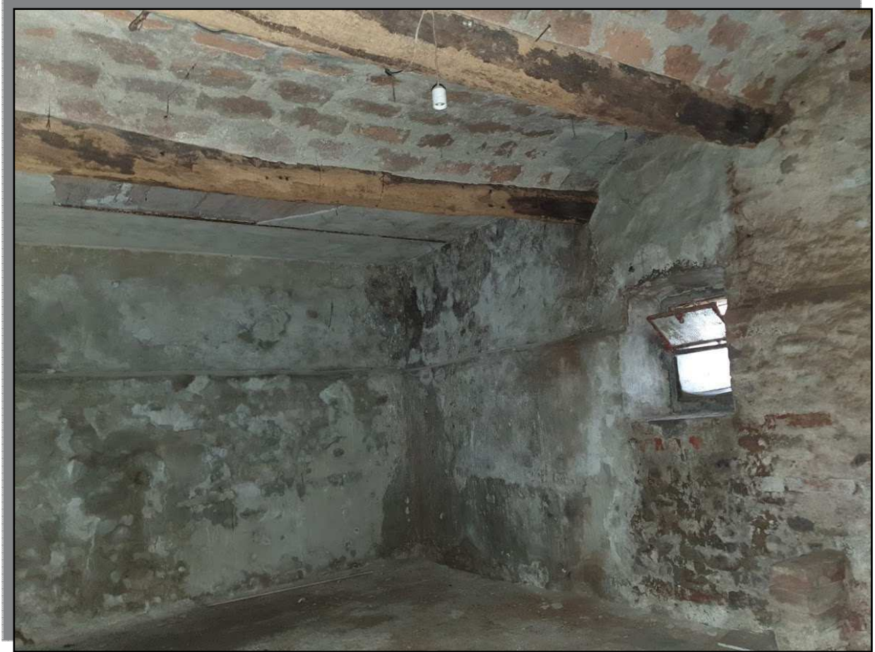
FOTO 5 _ PIANO TERRA: CANTINA
