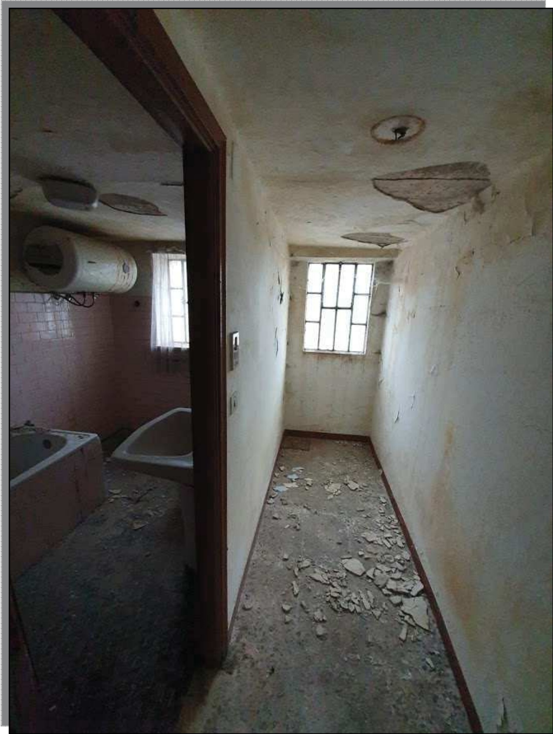
FOTO 2 _ PIANO TERRA: DISIMPEGNO E BAGNO
