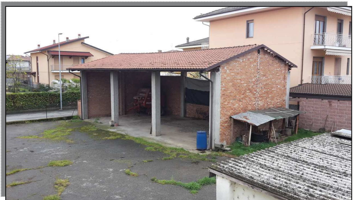
FOTO 10 _ FRONTE ANTERIORE NORD E FRONTE LATERALE EST
