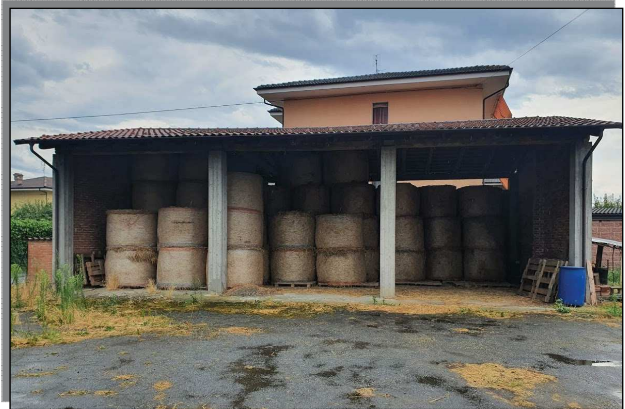
FOTO 7 _ FRONTE ANTERIORE NORD (SU CORTILE)
