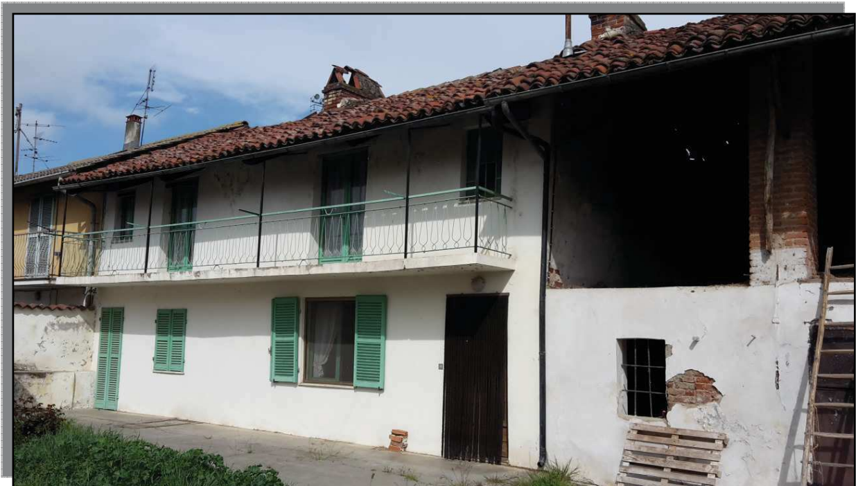
FOTO 3 _ FRONTE SUD: DETTAGLIO PORZIONE ABITATIVA
