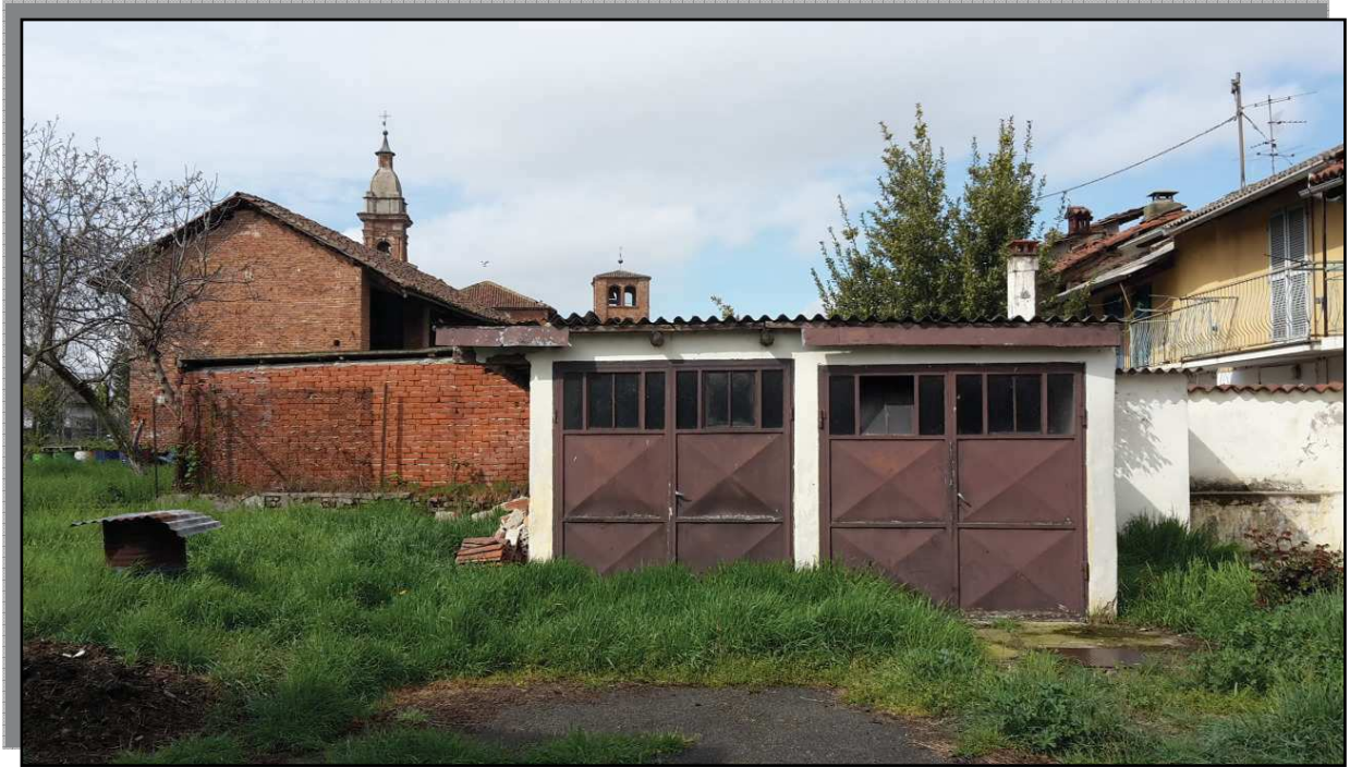
FOTO 11 _ FRONTE EST DI INGRESSO (SU CORTILE)
