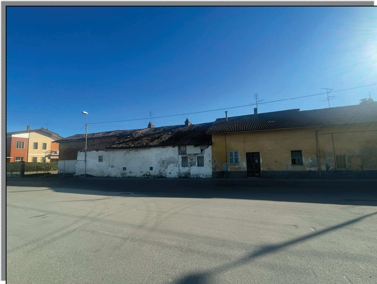
FOTO 6 _ FRONTE POSTERIORE NORD E VISTA SU VIA PASCHERETTO
