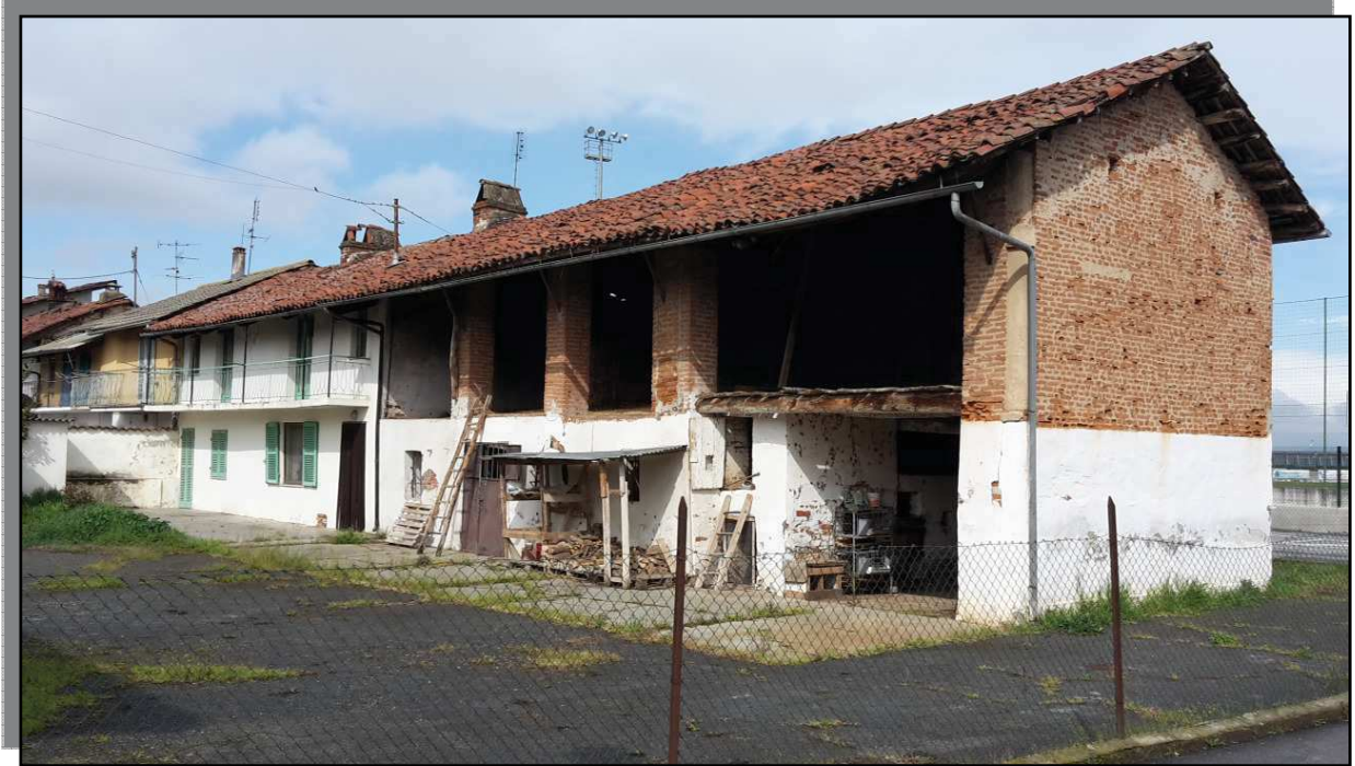
FOTO 2 _ FRONTE ANTERIORE SUD SU CORTILE
