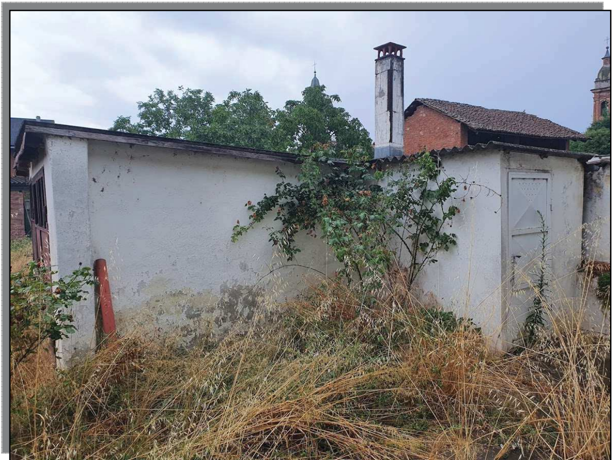
FOTO 13 _ FRONTE LATERALE NORD E VANO TECNICO
