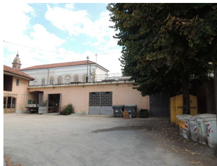
Foto 2 - Fabbricato accessorio - prospetto su cortile interno
